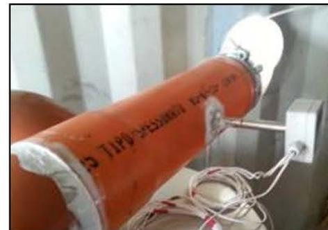
Sonda per misura umidità/temperatura dell'aria estratta (uscita analogica 0-10 Vdc)
