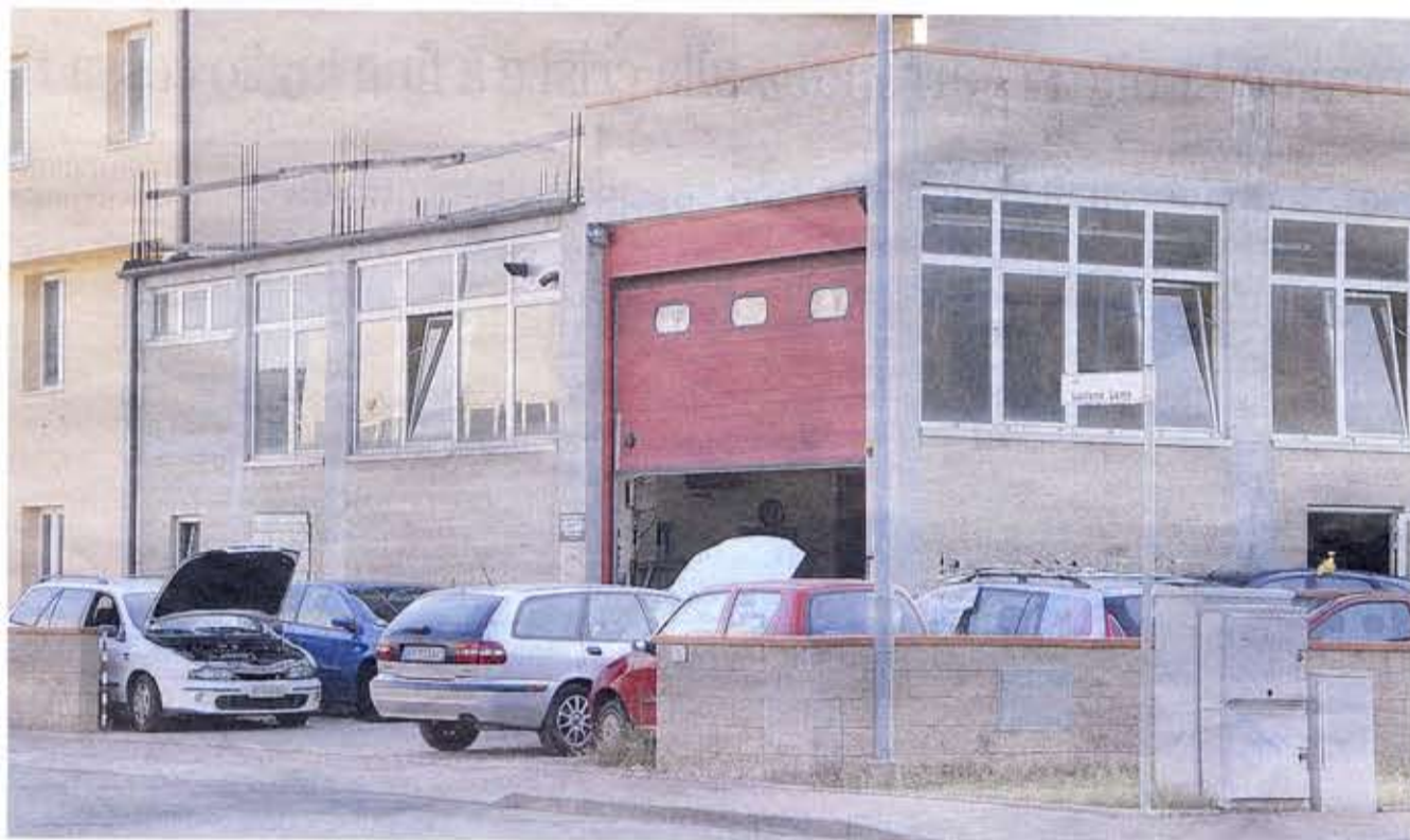
LA VERTENZA La sede della carrozzeria Autoservice, dove rischiano il posto 19 lavoratori, a Capraia e Limite
