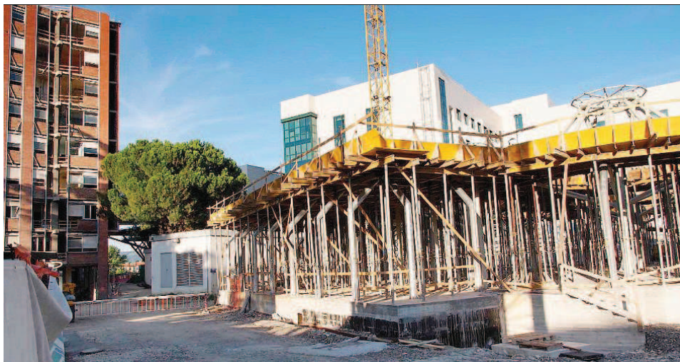
Il cantiere al San Giuseppe che avrebbe causato i fumi responsabili dei malori nelle sale operatorie
