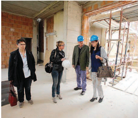
Il sopralluogo sul cantiere dell'Irsoo di Vinci
