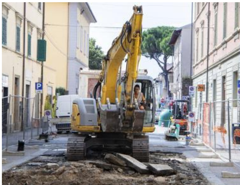
I lavori dei giorni scorsi: l'area pedonale adesso è stata completata ed è accessibile
